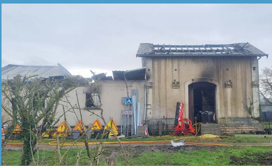
Le 8 janvier 2023 le local technique communal de Blou entièrement ravagé par les flammes
