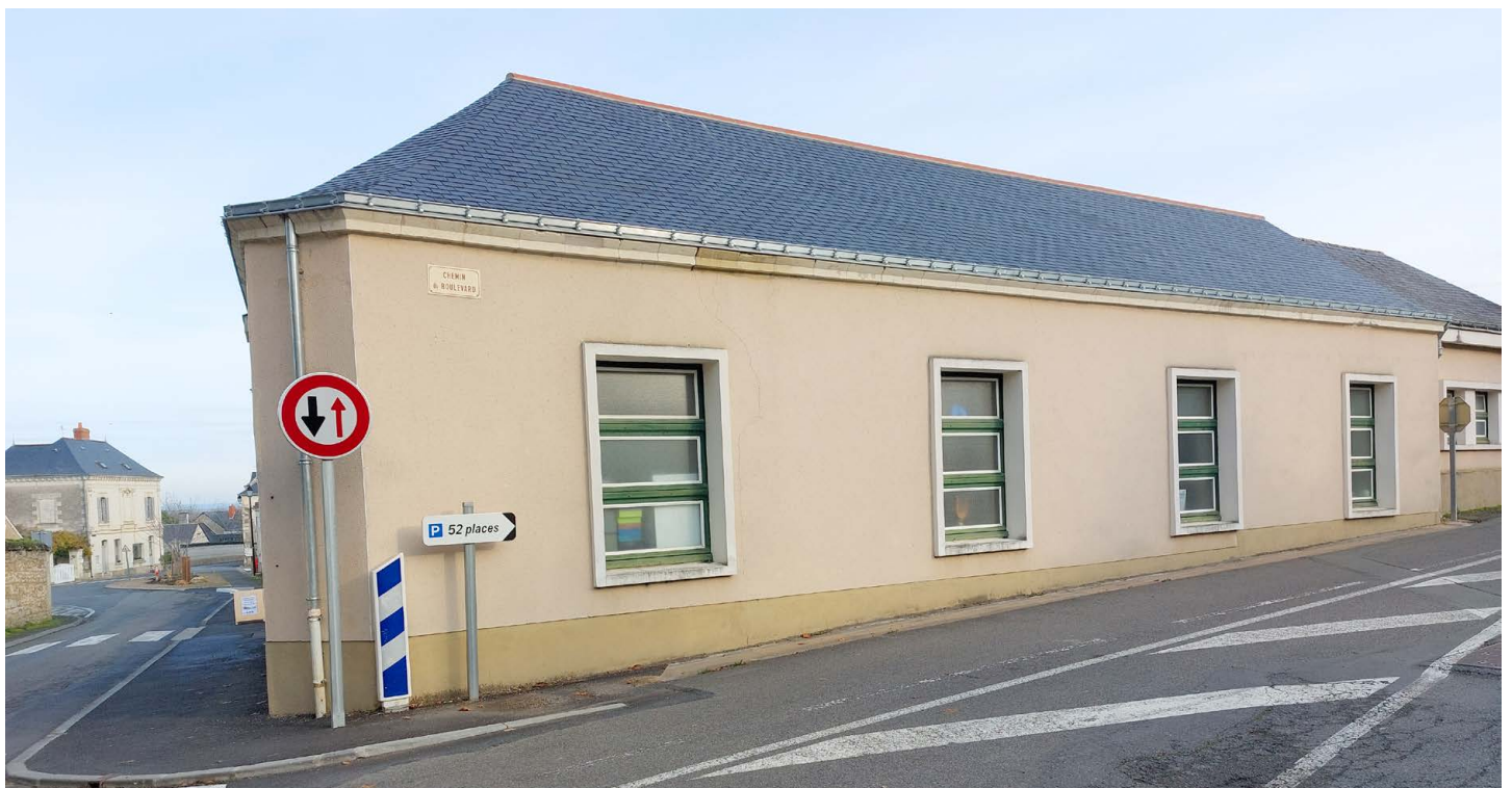
Une nouvelle toiture pour la salle de l'Harmonie
